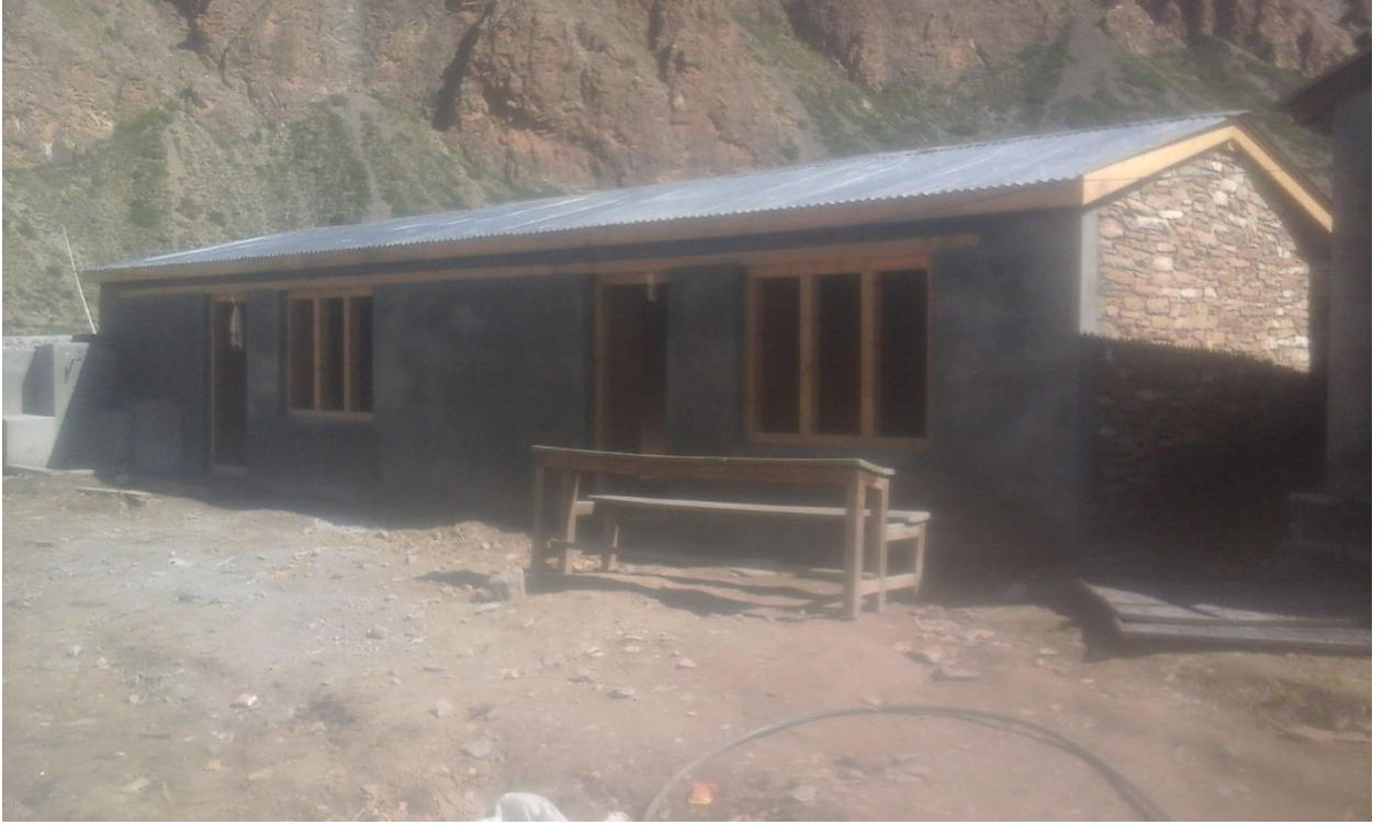
नार आधारभूत विद्यालय को स्तरोन्नती तथा पर्खाल निर्माण
