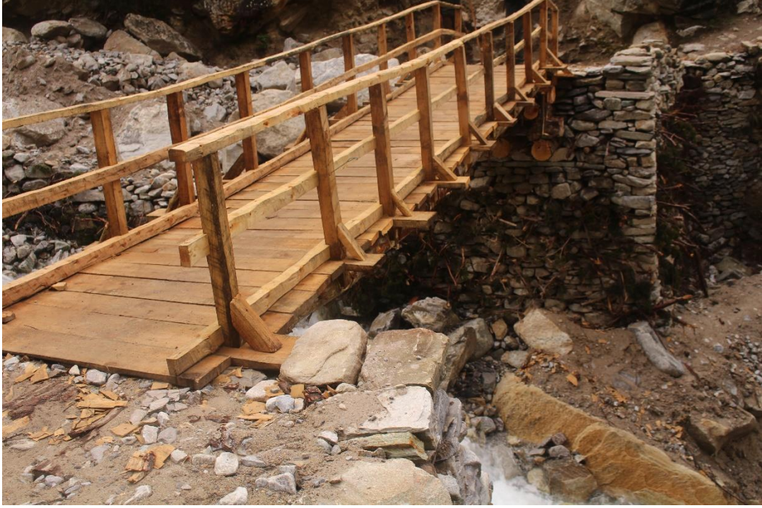
माछेखोलामा काठे पुल निर्माण
