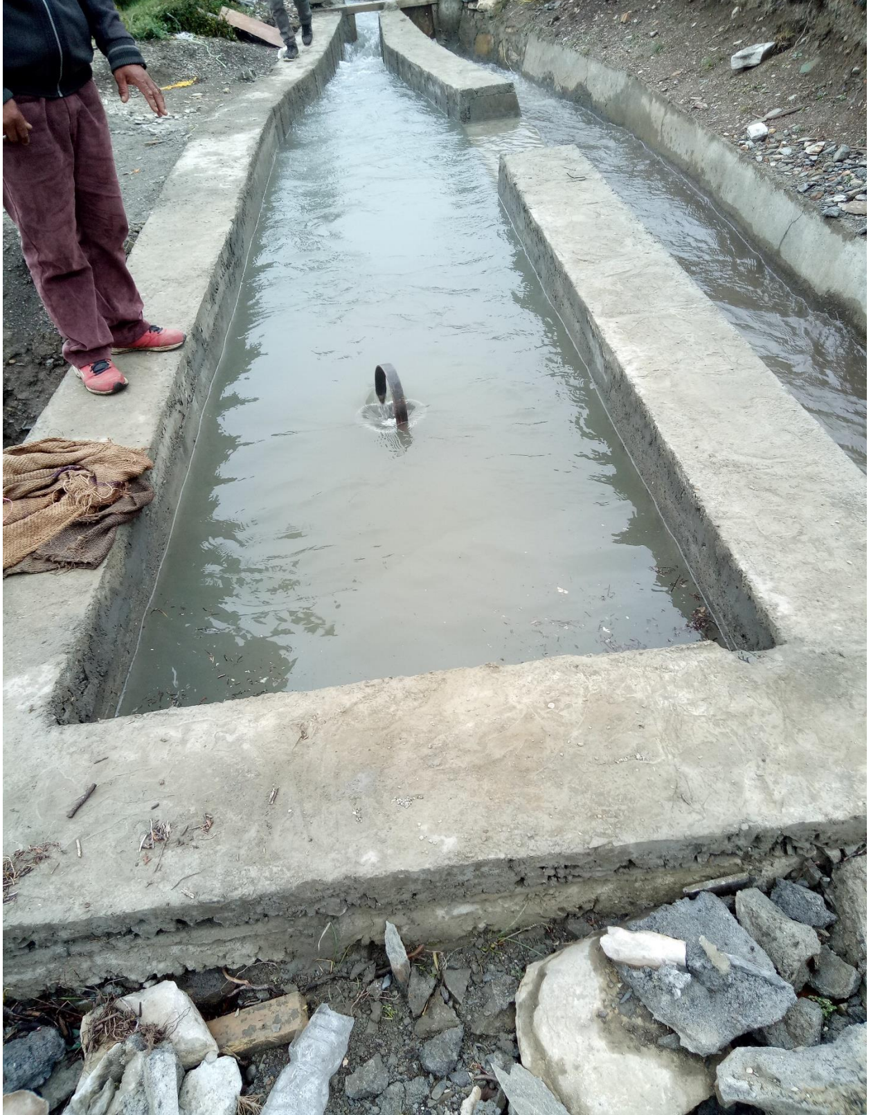
कामको था खोला जलविद्युत योजनामा Intake र Penstock कार्य
